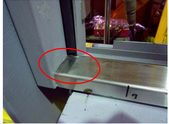
写真 14 下枠の擦りキズ (+1/60rad 除荷時)
