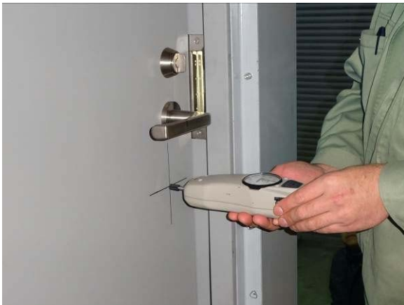
写真9 プッシュプルゲージによる戸の開放力測定状況
