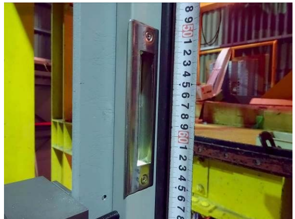
写真4 ストライクプレート
